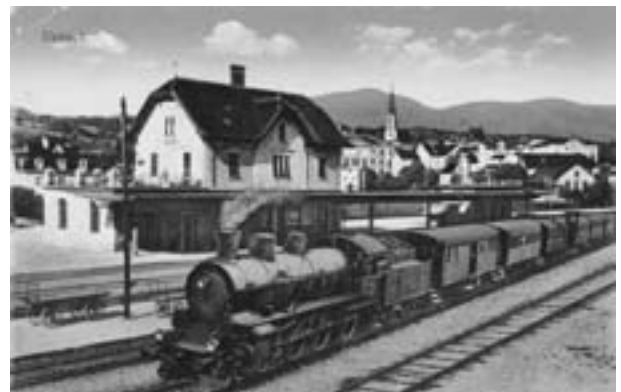
Schnellzug Chur – Rapperswil – Zürich auf dem Bahnhof Uznach (nach 1910) gezogen von einer Heissdampf-Vierzylinder-Verbundmaschine
