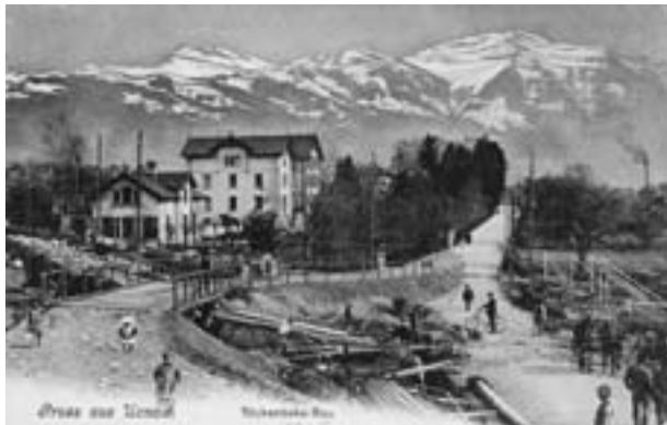
Bau der Rickenbahn (1908/1910); Brücke über die Bahnlinie in der Hinterstadt
