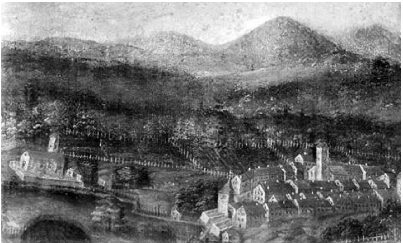
Darstellung der Stadt Uznach vor dem Brand von 1762 in der Linthport-Kapelle, gemalt ca. 1700. Die auf dem Felsen liegende Stadt wird von vier Zeilen von Steinhäusern gebildet. Hinter der Antoniuskirche mit dem schlanken Turm das Tönierspital. Im Westen bildet das untere Tor den Abschluss. Links die ummauerte Pfarrkirche Heilig Kreuz.
