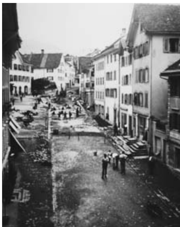
Die Hauptstrasse im Städtli erhält 1929 eine Pflästerung
