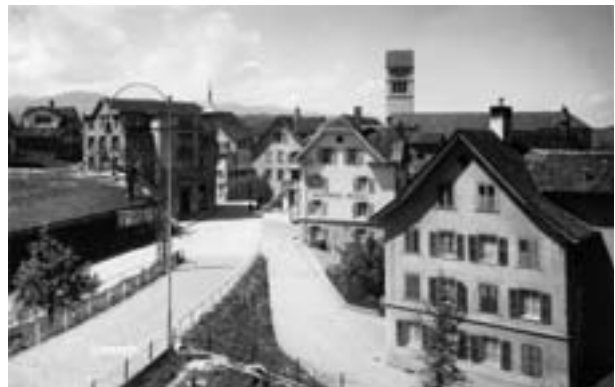
Rössliplatz vor den Abbrüchen des Restaurant Burg (1961) und des Wohnhauses von August Schubiger-Kühne (1984)
